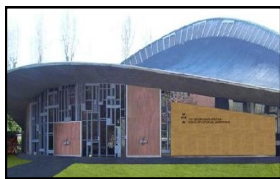
St-Augustin : 1 rue Dupleix Grenoble
