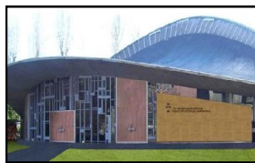
St-Augustin : 1 rue Duplex Grenoble
